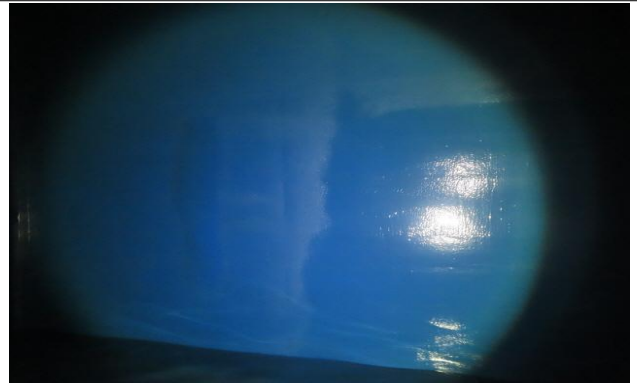
배수지 2지 도류벽 균열(0.3mm미만) 보수완료
