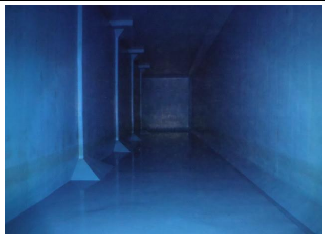
배수지 내부 전경
