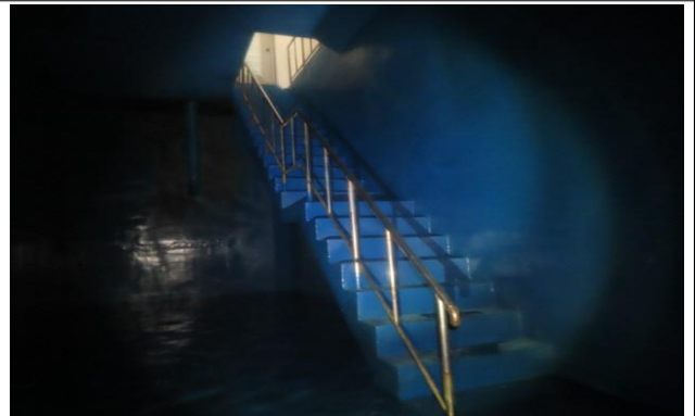
배수지 2지 난간 상태양호
