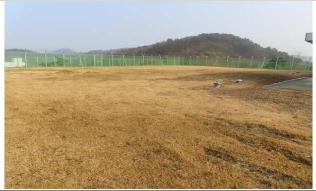
배수지 상부 상태양호
