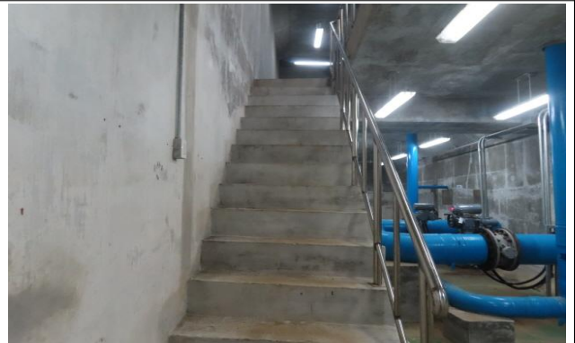
유출 밸브실 난간 상태양호
