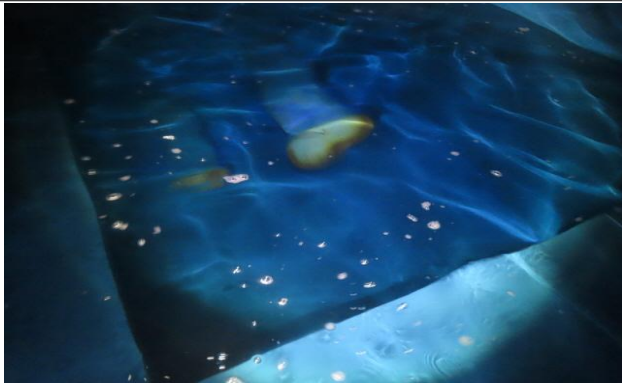
배수지 2지 하부슬래브 도장손상 보수완료
