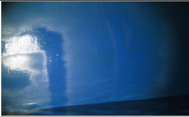
배수지 2지 벽체 균열(0.3mm미만) 보수완료
