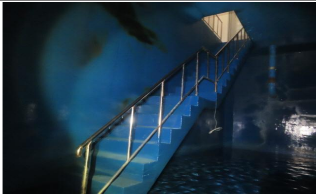
배수지 1지 난간 상태양호
