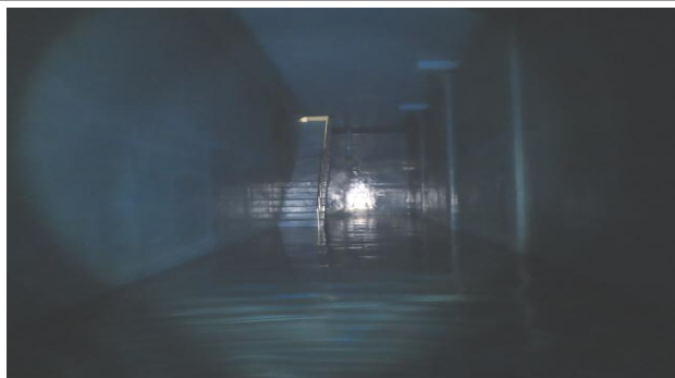
배수지 1지 내부 전경
