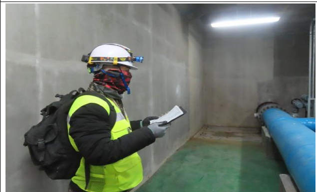
유·출입 밸브실 외관조사
