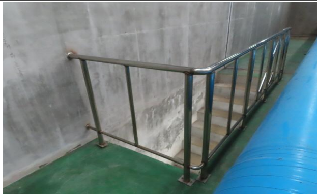
유입 밸브실 난간 상태양호
