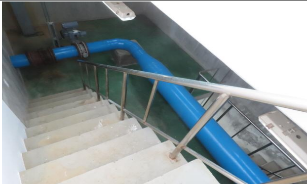
유입밸브실 난간 상태양호
